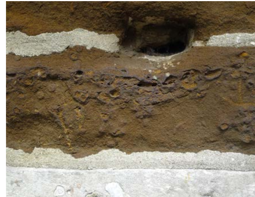
Detailfoto van ijzerzandsteen met verharde limonietkorst
